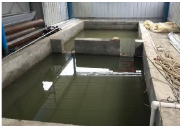
预制场循环沉淀池
