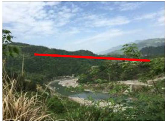
大坪涪江大桥桥位
