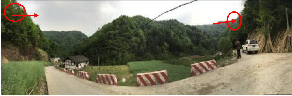
谢家平隧道出口-石川子隧道进口
