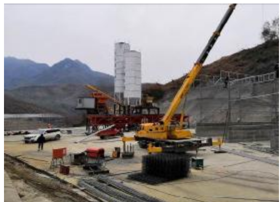
施工场地建设
