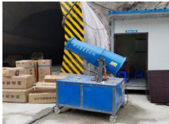
隧道口雾炮机除尘
