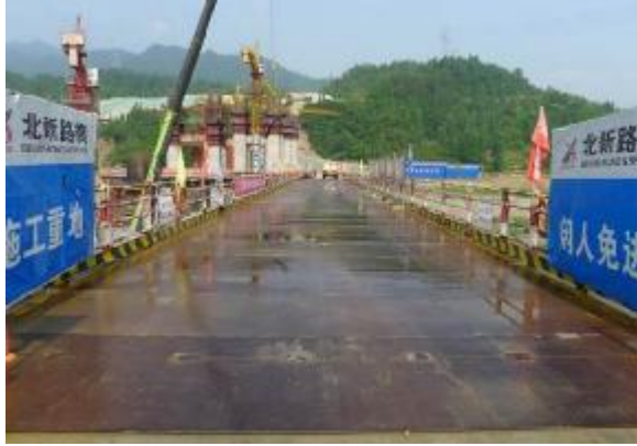
白龙湖大桥施工便桥
