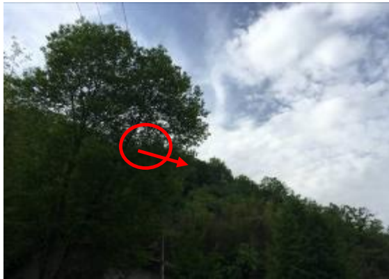
白杨坪隧道出口
