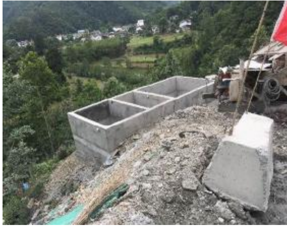
隧道口沉淀池
