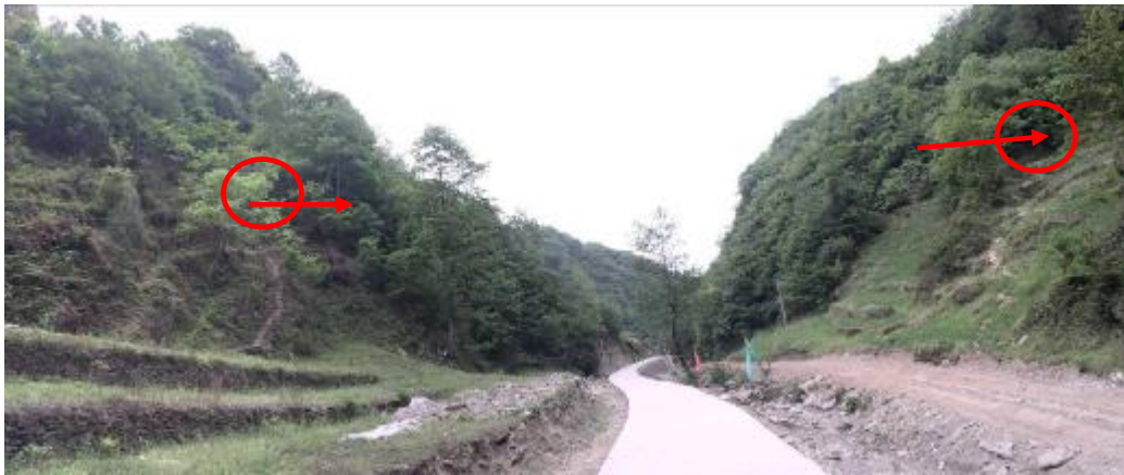
黄坪隧道出口-谢家坪隧道进口
