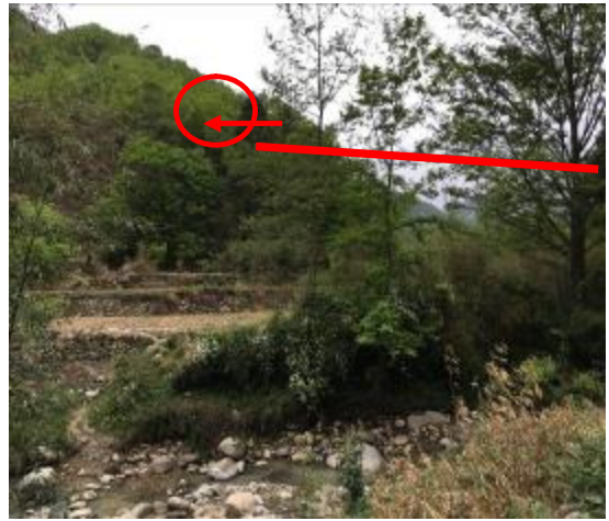
大田坝中桥桥位及白杨坪隧道进口
