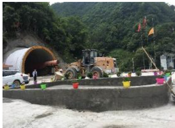
隧道口自动化洒水降尘池
