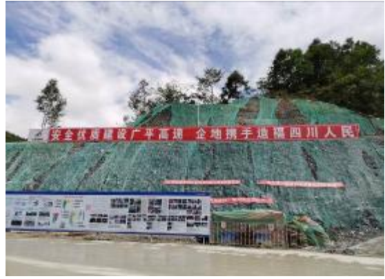
施工开挖面遮挡
