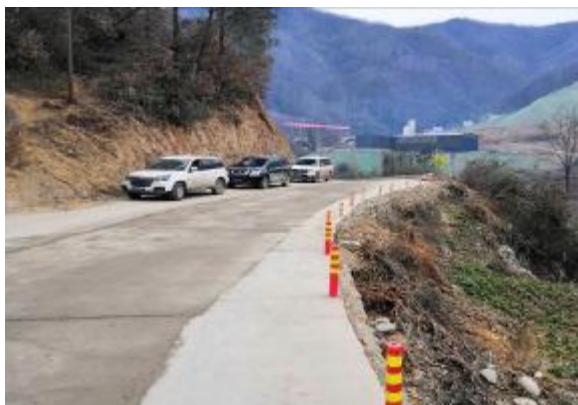
施工便道改扩建
