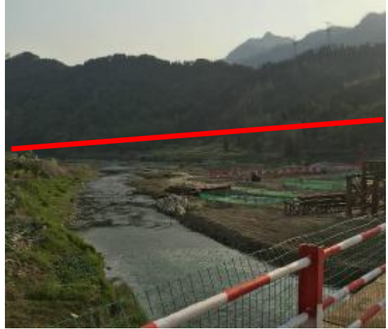
白龙湖大桥桥位
