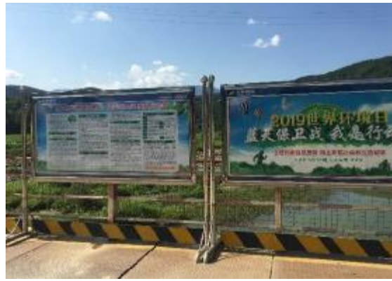
施工期施工场地环保标牌
