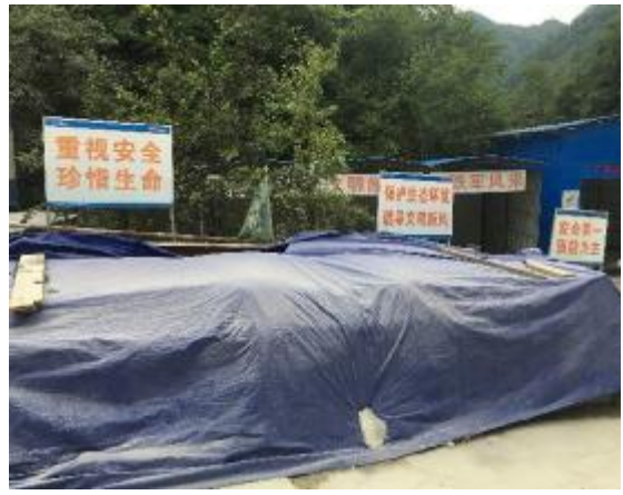
施工场地物料遮挡
