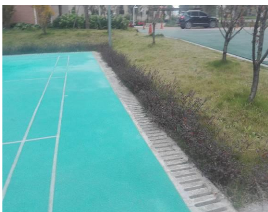
排水设施现场照片 (3)
