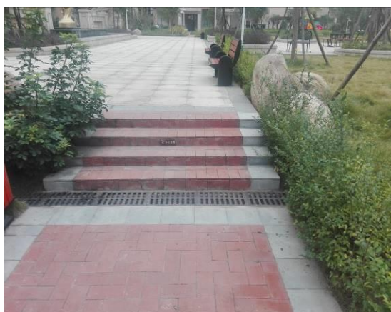
排水设施现场照片 (4)
