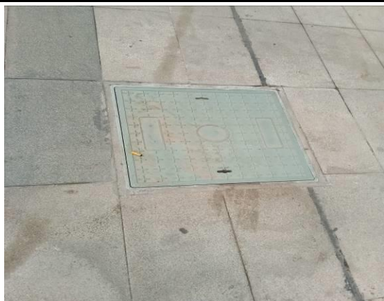
排水设施现场照片 (1)
