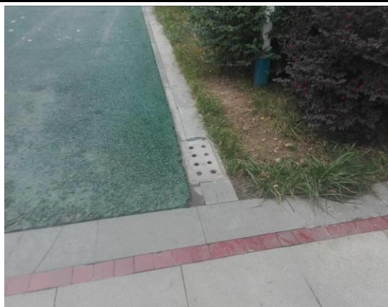
排水设施现场照片 (2)
