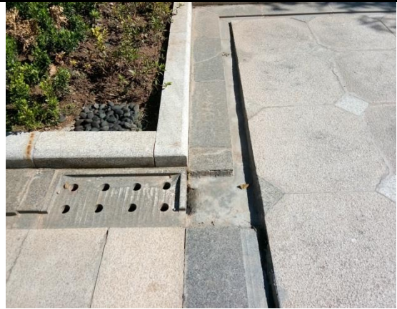
排水设施实施后情况 (18)
