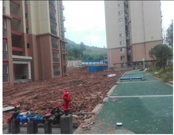
排水设施实施期间照片（6）
