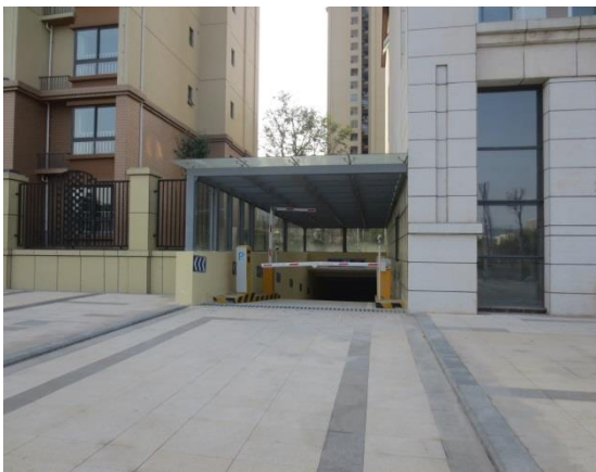
排水设施实施后情况（3）
