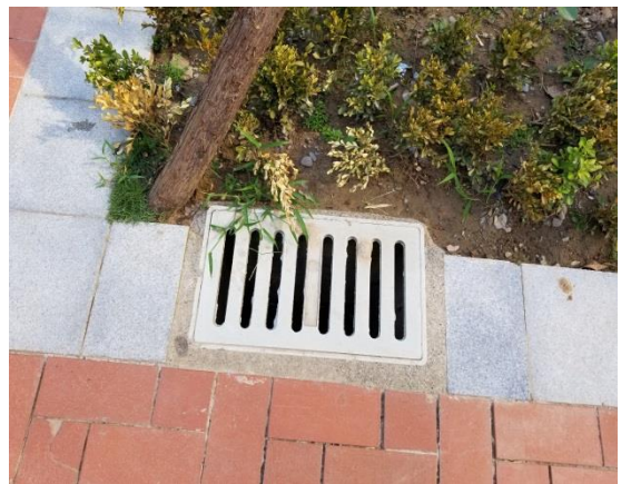
排水设施实施后情况 (10)
