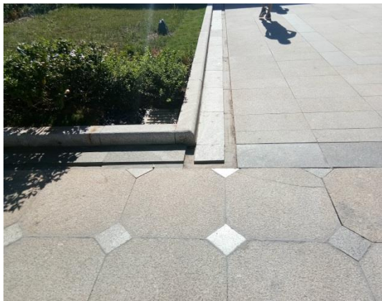
排水设施实施后情况 (19)
