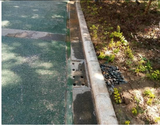
排水设施实施后情况 (11)
