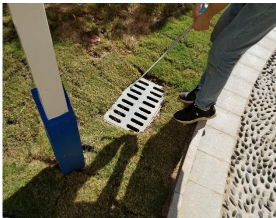
排水设施实施后情况 (9)
