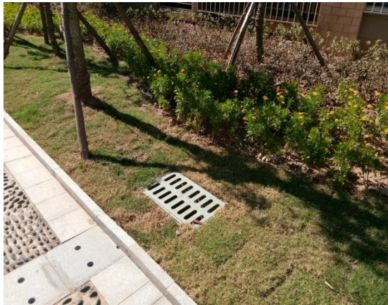
排水设施实施后情况 (13)
