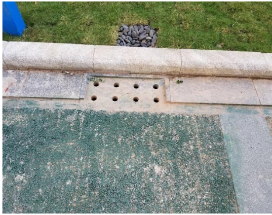
排水设施实施后情况 (7)
