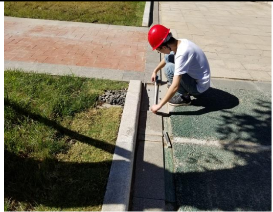
排水设施实施后情况 (6)
