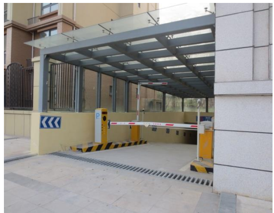
排水设施实施后情况（4）
