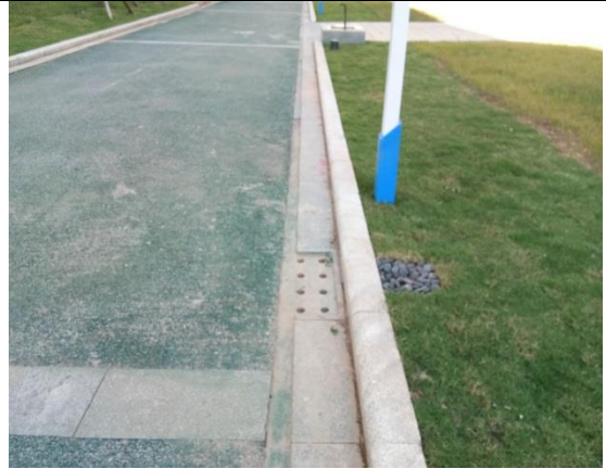
排水设施实施后情况 (12)
