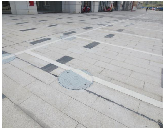
排水设施实施后情况（2）
