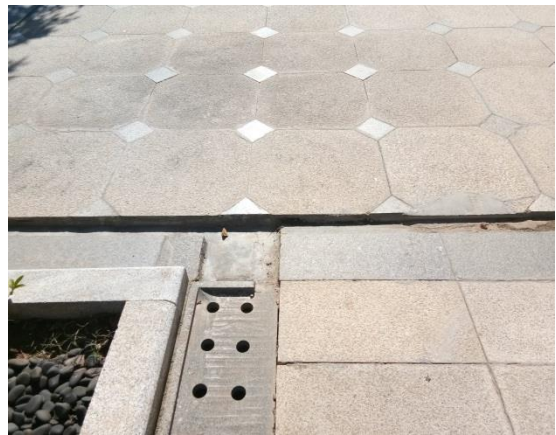
排水设施实施后情况 (20)
