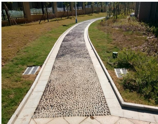
排水设施实施后情况 (15)
