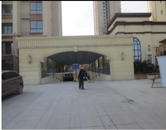
排水设施实施后情况 (5)
