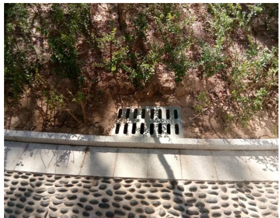
排水设施实施后情况 (16)
