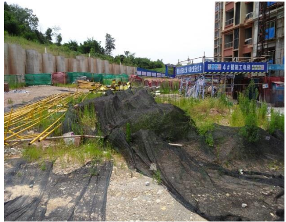
临时防护措施实施情况 (2)
