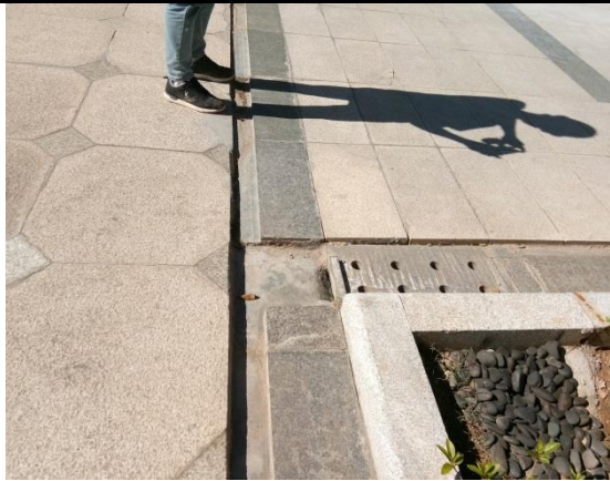
排水设施实施后情况 (17)
