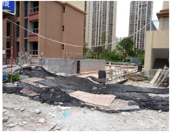
临时防护措施实施情况 (1)
