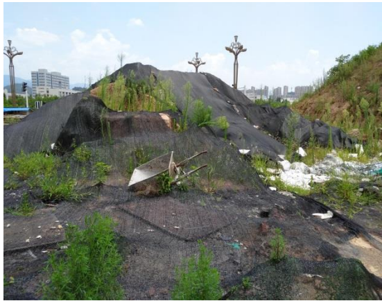
临时防护措施实施情况 (2)
