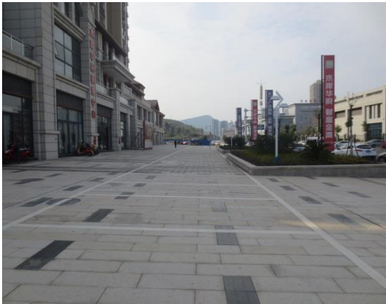
排水设施实施后情况（1）
