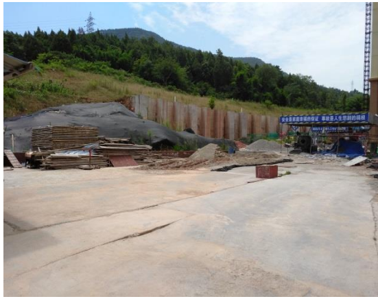
临时防护措施实施情况 (1)
