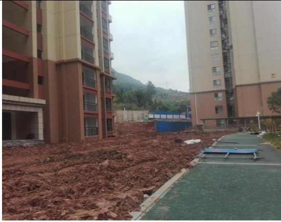
排水设施实施期间照片（5）
