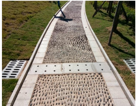
排水设施实施后情况 (14)
