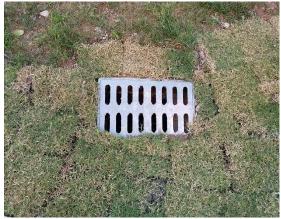
排水设施实施后情况 (8)
